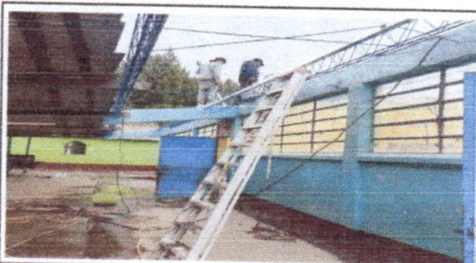
Foto 4: Cambio de techo por lamina aluzinc calibre 26, con su respectiva costanera.
