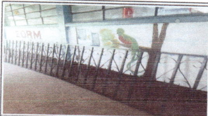
Foto 1: Colocación e instalación de balcones de hierro en ventanas de aulas y cocina.
