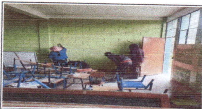
Foto 6: Pintando la otra parte de muros exteriores e interiores.
