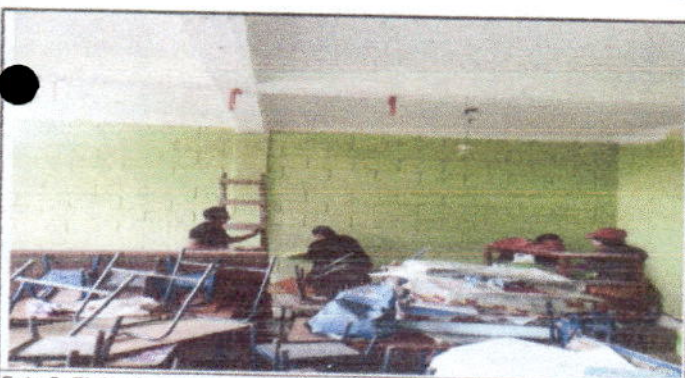
Foto 5: Pintando los muros exteriores e interiores en aulas
