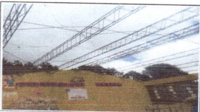
Foto 3: Cambio de techo por lamina aluzinc calibre 26.
